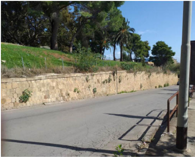
Lato Via Rocco Chinnici
