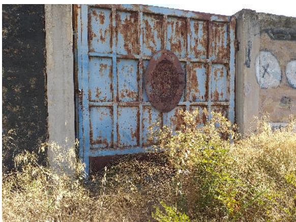
Ingresso da Via Tommaso Lucentini
